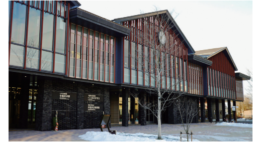
คุสุริกาเกะ เทอร์เรซ สถานีรถไฟนากะคารูอิซาว่า
