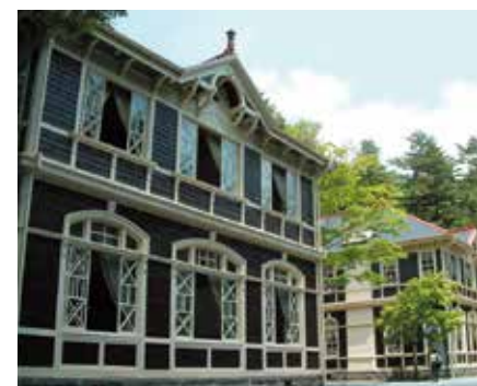
▲ 1904年(明治37)に建てられた旧三笠ホテル 改修工事中 令和7年度開館予定
