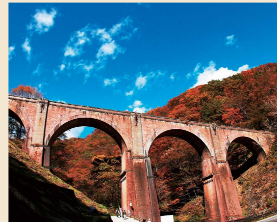
群馬県安中市 第三橋梁(通称めがね橋)
