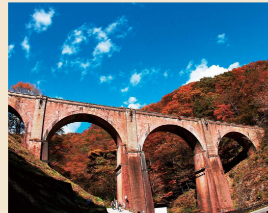
群馬県安中市 第三橋梁(通称めがね橋)
