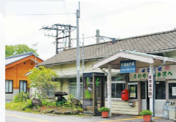
大正12年築 / 停車場規定5等級2号設計図に基づいて造られました。
