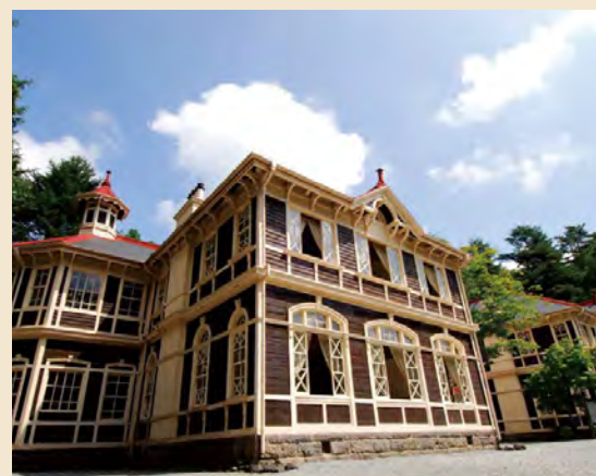
長野県軽井沢町 重要文化財・旧三笠ホテル ※改修工事のため休館中 (令和7年開館予定)
